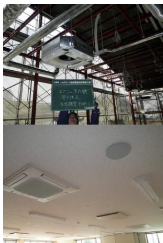
空調・換気設備工事
