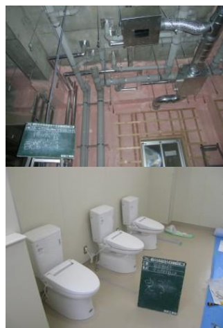
給排水・給湯設備工事
